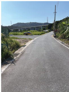
町道伊芸13号線
