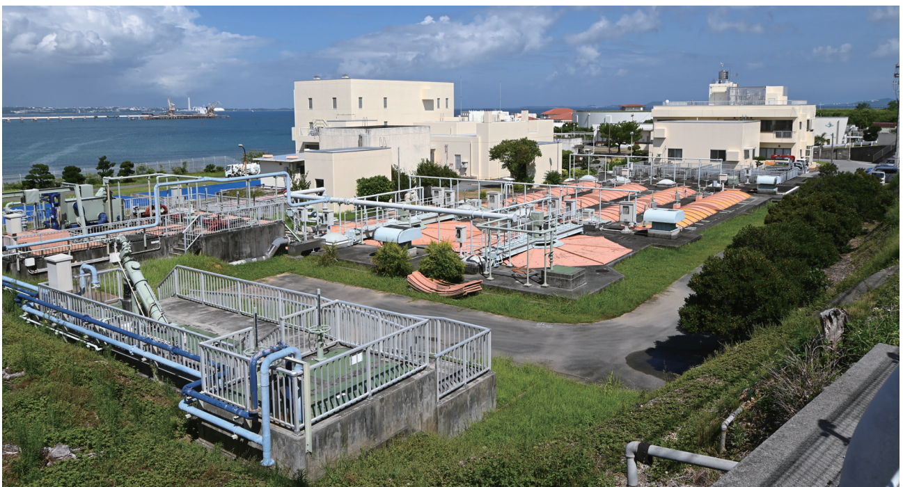
うるま市が老朽化廃止を検討している石川終末処理場。金武町内の浄化槽から汲み取ったし尿の処理を委託している。
