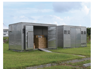
ギンバルに設置している防災備蓄倉庫
