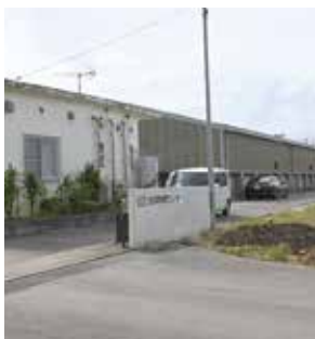
金武有機堆肥センター
