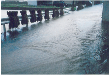
冠水時の町道伊芸7号線
