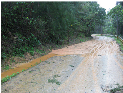
赤土流出の状況
