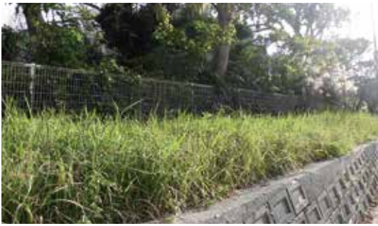
擁壁を設置予定の嘉芸小学校西側
