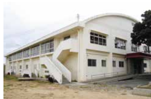
未耐震の金武中体育館
