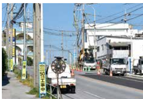
電線地中化工事
