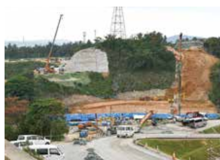
工事が進むキャンプ・ハンセン新設ゲート
