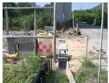
途中で切れている側溝
