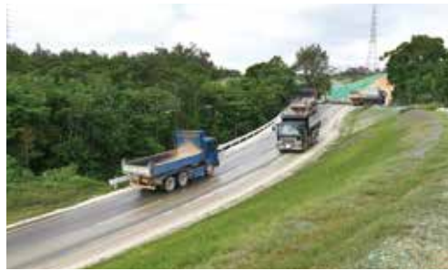
土砂を運搬をするダンプ (キャンプ・ハンセンアクセス道路工事)
