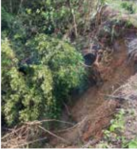
名古屋川の流水で削られているのり面
