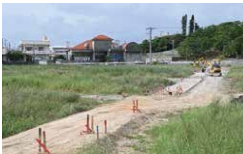
水田かんがい施設整備工事
