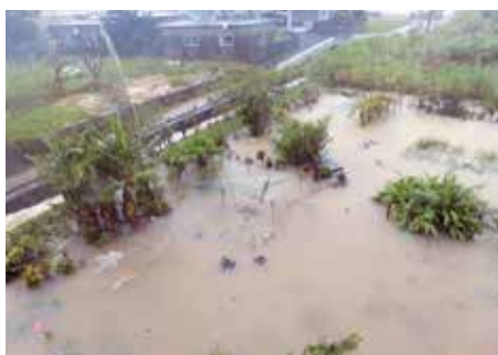
大雨時に氾濫する山田川
