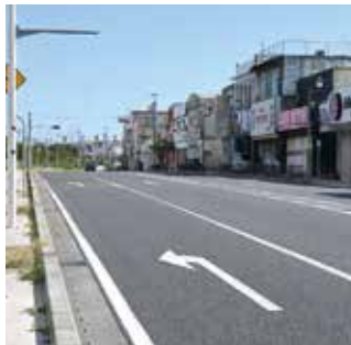
交通量が減少した国道329号
