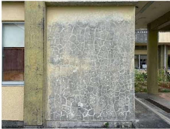
構造部材/中庭 壁面(アルカリシリカひび割れ)
