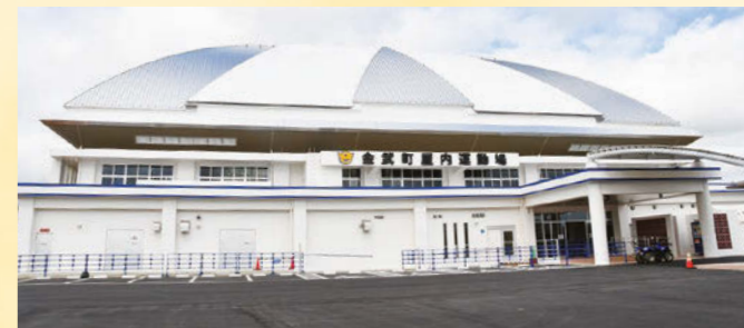
▲金武町多目的屋内運動場
