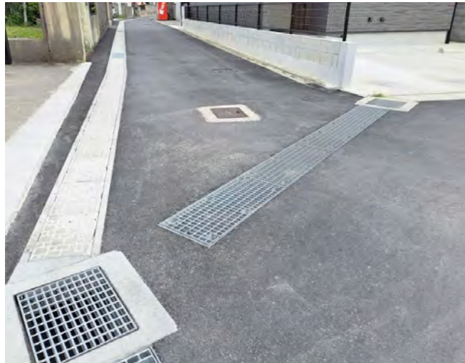
整備した側溝（伊芸区平田原）
